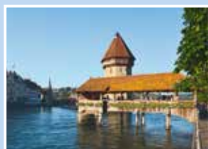
Kappelbrücke, Kanton Luzern
